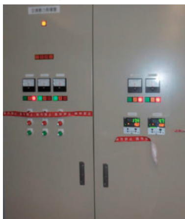
写真1 空調制御盤
