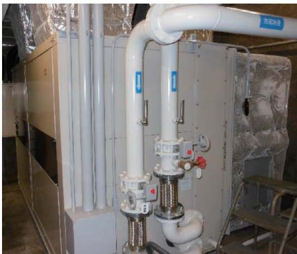
写真2 水冷式外気処理エアコン
