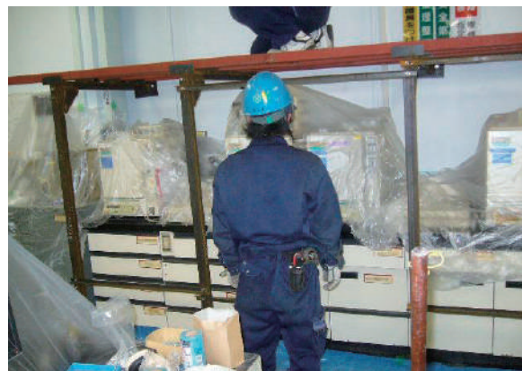
写真4 機材養生用架台設置状況
