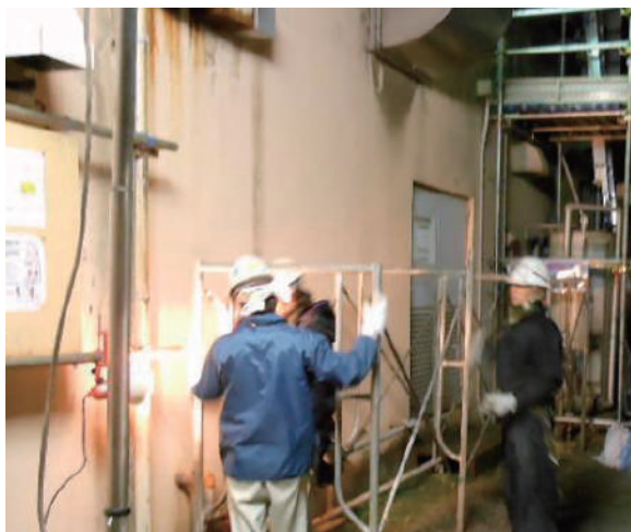
写真3 外部ステージ組立の様子
