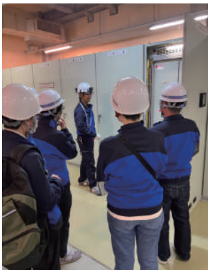
道路管理所電気室見学
